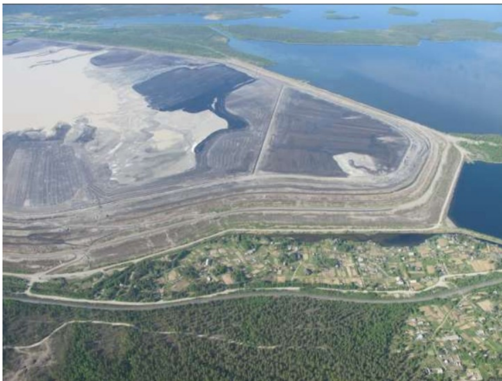
Рис. 1.1. Северо-западная часть хвостохранилища АНОФ-2 [17]
