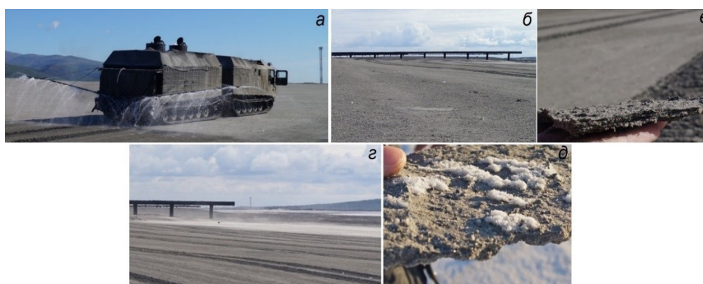
Рис. 1.14. Нанесение раствора реагента на поверхность хвостов (а), покрытие из связанных песков (б), сформировавшаяся «корка» на поверхности хвостов (в), граница между закрепленной экспериментальной площадкой и соседним необработанным участком хвостохранилища (г), «корка» на поверхности хвостов в зимний период (д)
